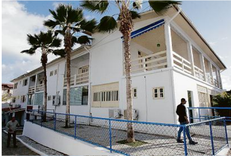
Abrigo D. Pedro II passa a funcionar em Piatã; prédio da Boa Viagem terá de passar por reforma
