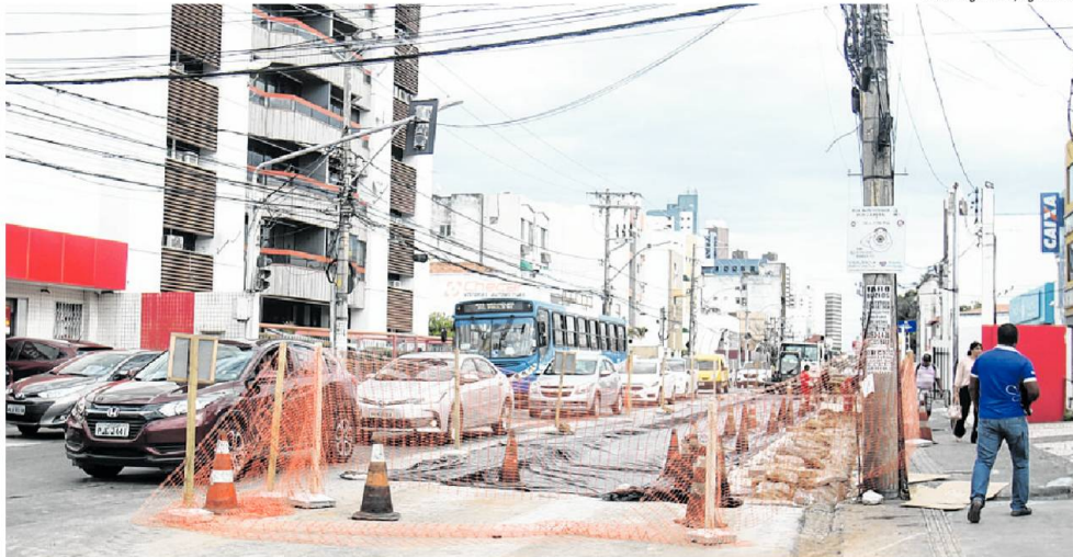
Ação que alterou o fluxo de veículos é realizada na via exclusiva de ônibus pela Superintendência de Obras Públicas do Salvador (Suop)
