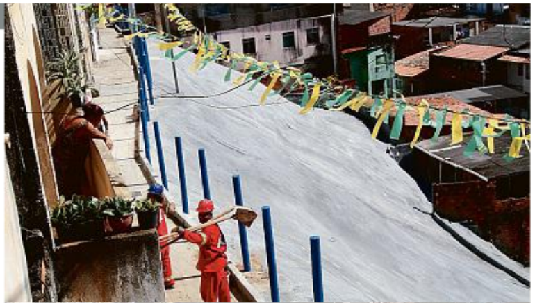
A técnica de impermeabilização do solo cobre 2.832 metros de área e vai beneficiar 160 famílias
