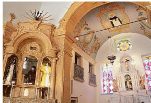
A obra incluiu recuperação de revestimentos e da instalação elétrica
