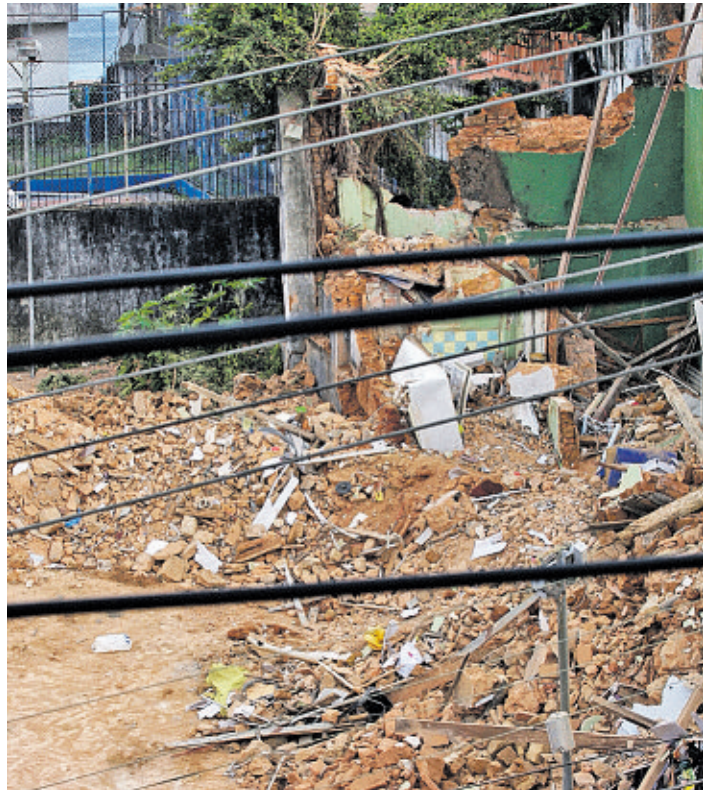
Imóvel desabou deixando três mortos e dois feridos
