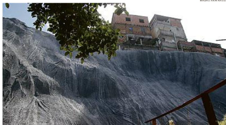
O material, formado por um composto de PVC e geotêxtil, impermeabiliza o talude e tem duração de 5 anos
