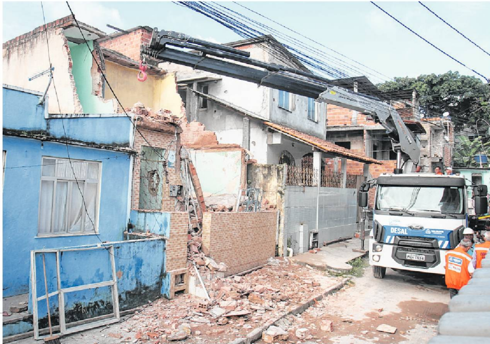
Equipe da Defesa Civil realiza demolição do que sobrou da casa localizada na rua da Esperança, bairro de Plataforma, na tarde de ontem
