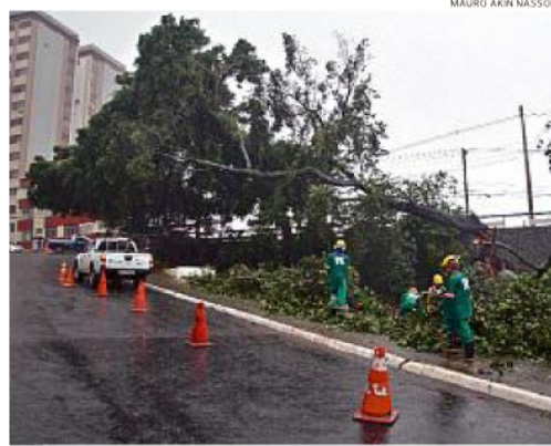
Árvore caída no acesso à Av. Centenário; via na Federação foi interditada
