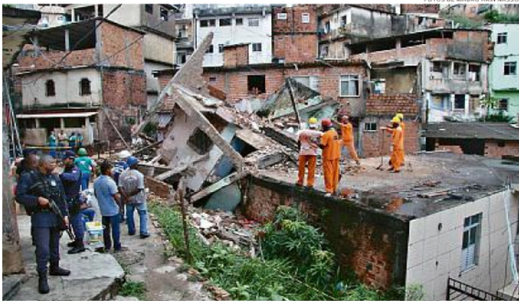
Técnicos da Sedur fizeram a demolição manual do prédio, interdito desde 2015 por risco de desabamento
