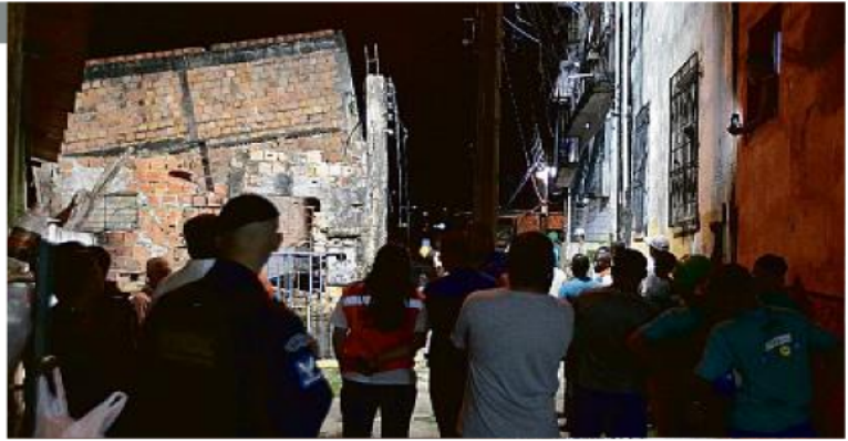
Imóvel já tinha sido vistoriado antes pela Defesa Civil, que constatou problemas de rachaduras em pilares
