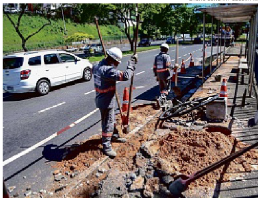
O furto de cabos e equipamentos da iluminação pública segue em alta em Salvador
