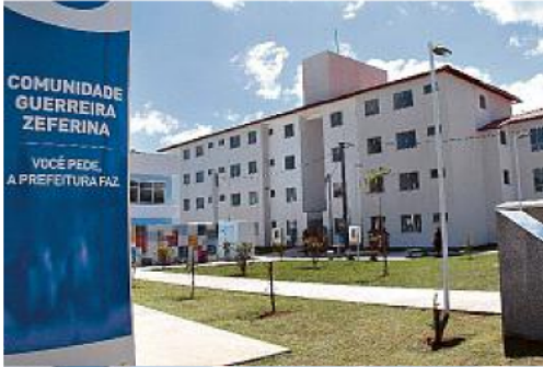
Prefeitura entrega 125 apartamentos nessa primeira fase das obras
