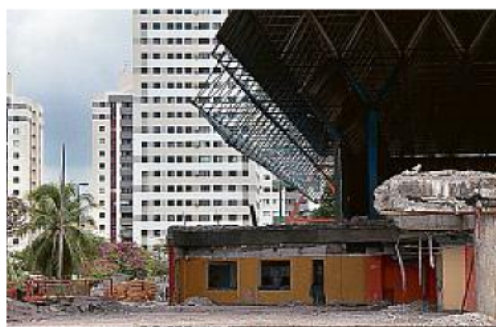
O concreto e o ferro retorcido que bloqueavam o vão central foram retirados
