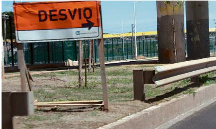
Guard rails na Paralela passaram por vistoria da Transalvador, ontem; órgão vai reforçar fiscalização
