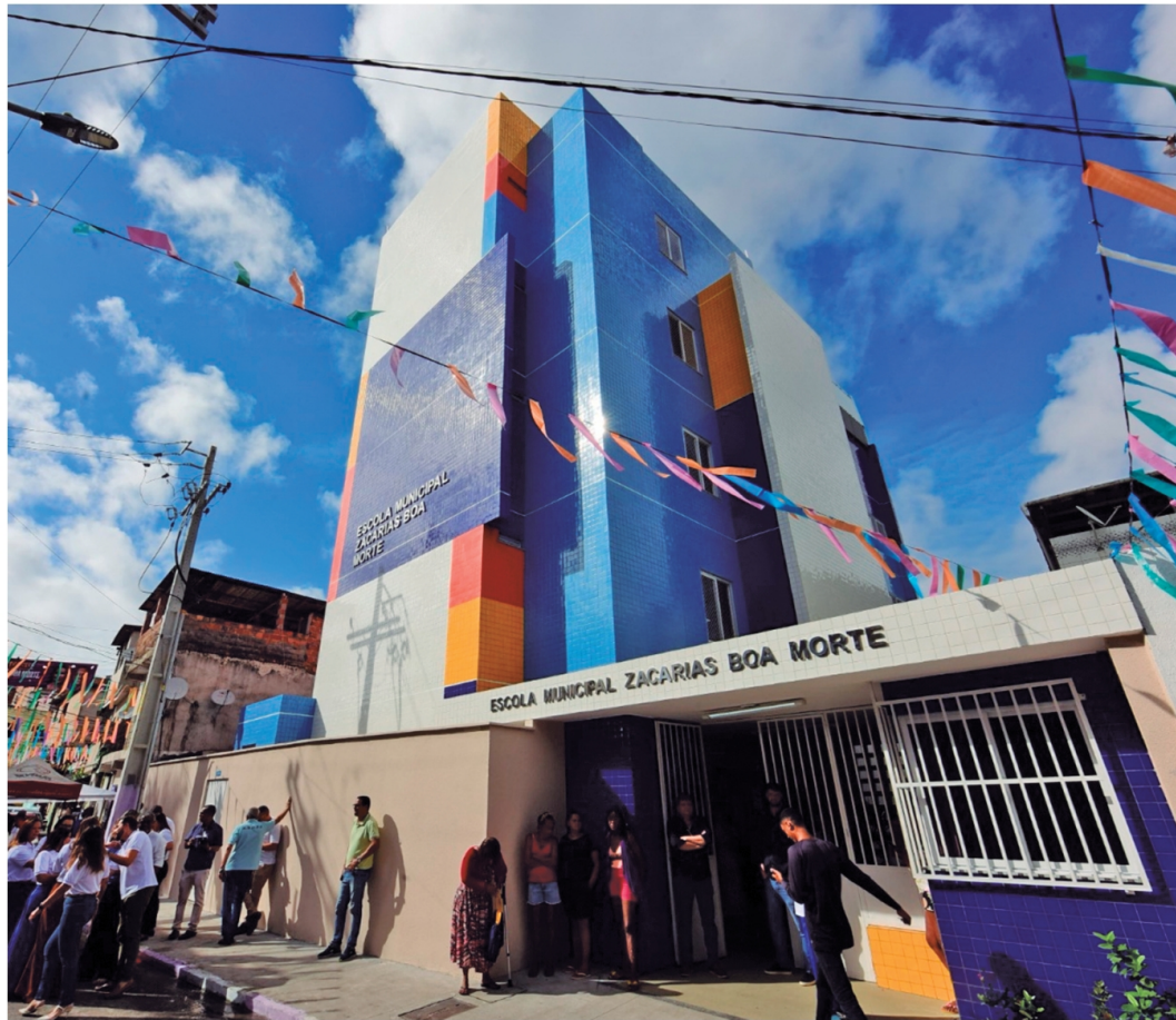
Escola Municipal Zacarias Boa Morte, no bairro do Pero Vaz, foi reformada e teve a capacidade de estudantes ampliada de 150 para 300
