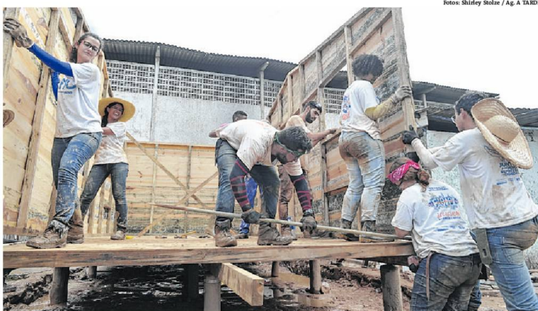
Colaboradores dão duro para levantar casa pré-moldada de até 18 metros quadrados, no bairro de Paripe
