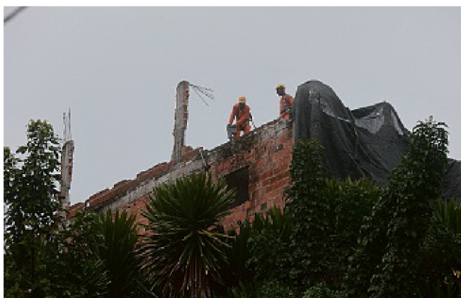
A destruição está sendo feita manualmente para não impactar os locais próximos da obra
