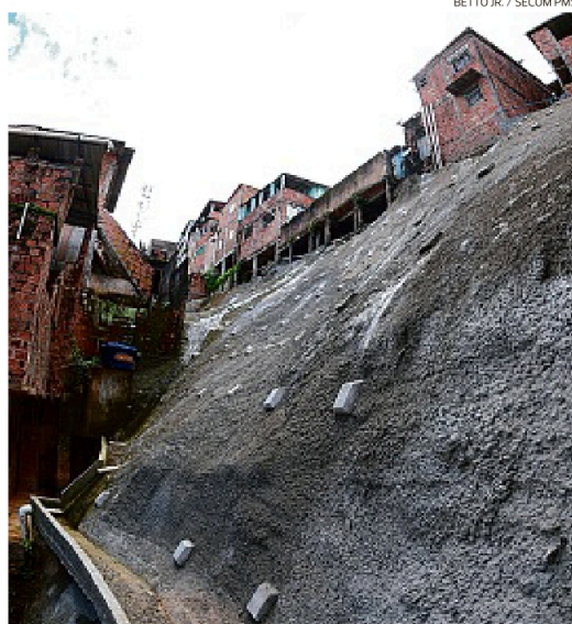
Foram investidos R$ 2,2 milhões para a construção das duas proteções
