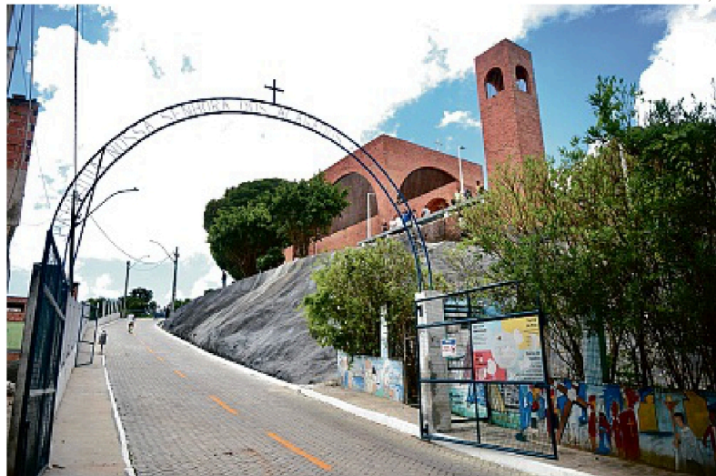
Local ganhou infraestrutura e acessibilidade, com investimento de cerca de R$ 6,3 milhões
