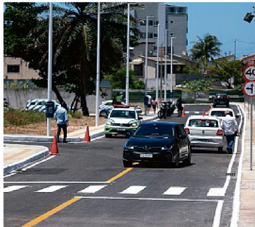
Rua tem 700 metros e vai encurtar o deslocamento em 10 minutos
