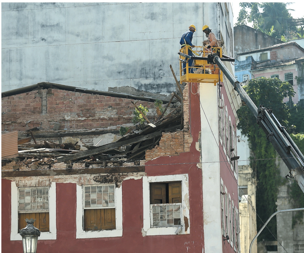
Seidur iniciou demolição de partes do casarão usando guindastes: operação é feita manualmente na Praça Conde dos Arcos
