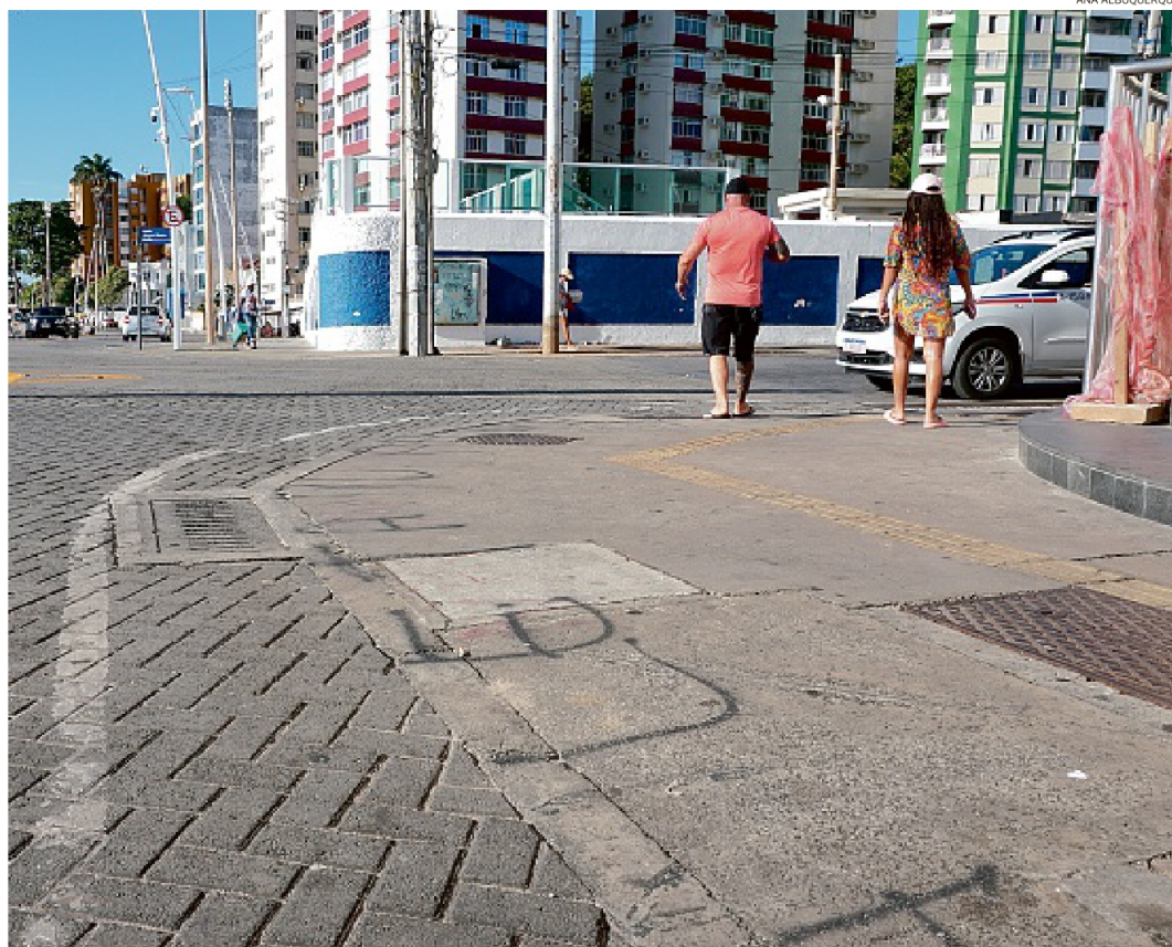
A Secretaria Municipal de Ordem Pública iniciou operação para eliminar as marcações feitas por ambulantes nos locais designados para o Carnaval
