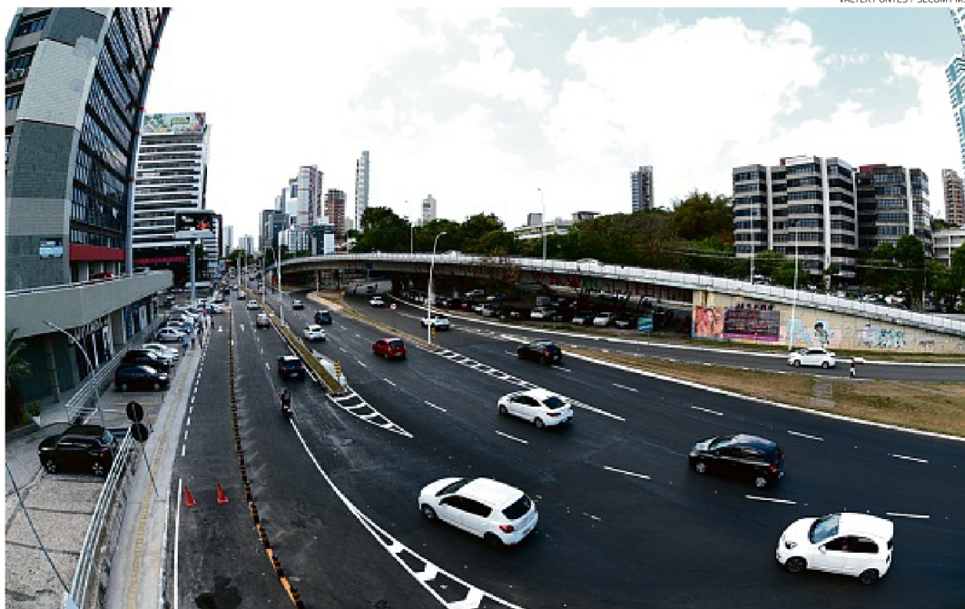
Trânsito na Avenida Tancredo Neves ficará mais ágil após intervenção. Obra integra pacote de outras seis melhorias na cidade
