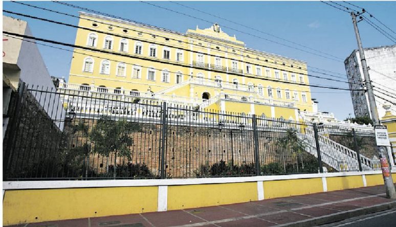
No Lar Franciscano Asilo Santa Isabel foram concluídas a reforma e a pintura da fachada, além da iluminação cênica
