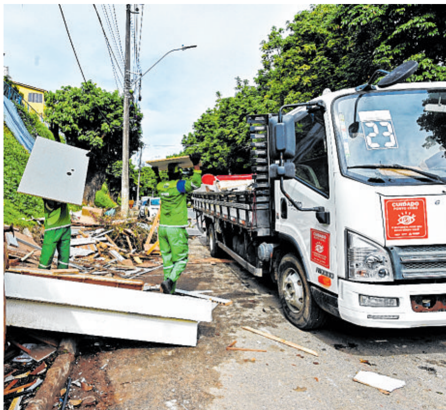
Limpeza de entulho na Rua Padre Domingos de Brito, na Federação
