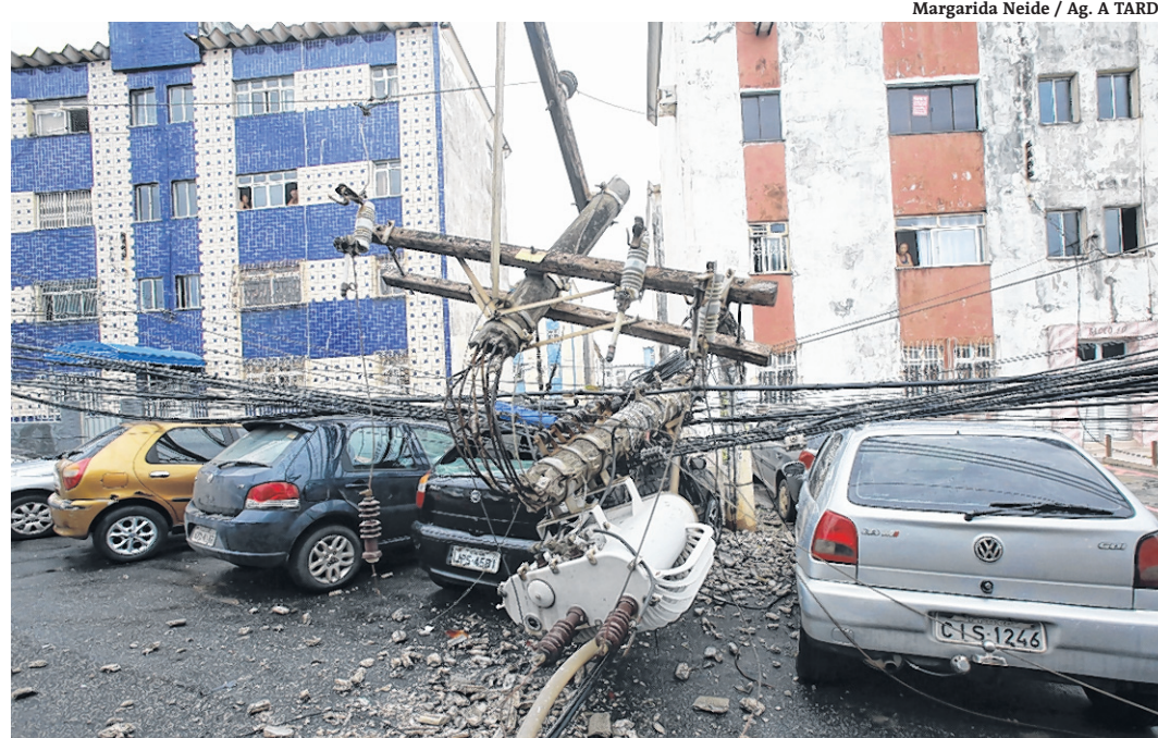
Poste atingiu veículos e deixou moradores sem fornecimento de energia elétrica
