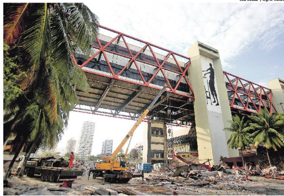
NOVO CENÁRIO | Iniciado em dezembro de 2017, o trabalho de desmonte de parte da estrutura que desabou no Centro de Convenções da Bahia, em Armação, seguiu no dia de ontem. A previsão é de que a etapa de remoção de materiais seja finalizada em abril.
