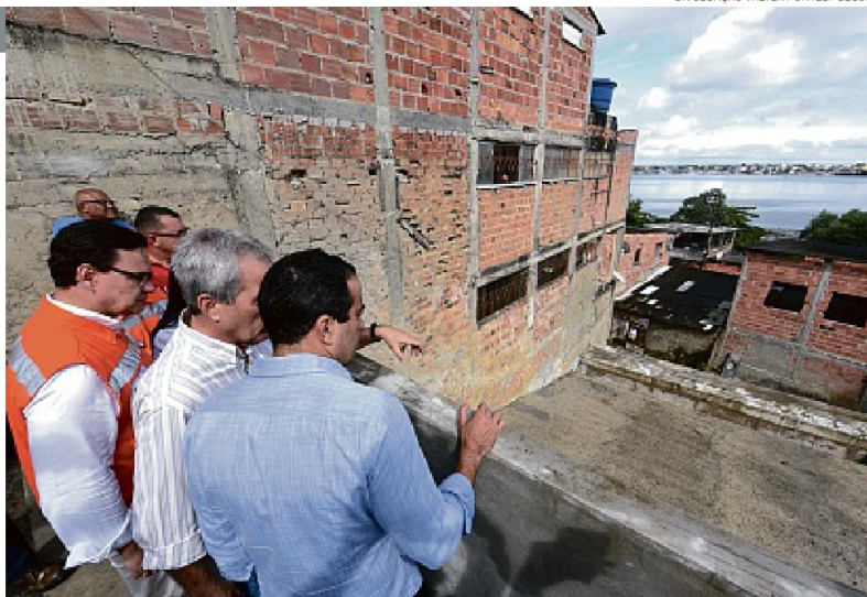
O prefeito Bruno Reis na Rua Getúlio Vargas do Lobato, durante inauguração da obra
