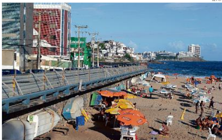
Ordem de serviço foi assinada ontem à tarde pelo prefeito ACM Neto; obras começam imediatamente
