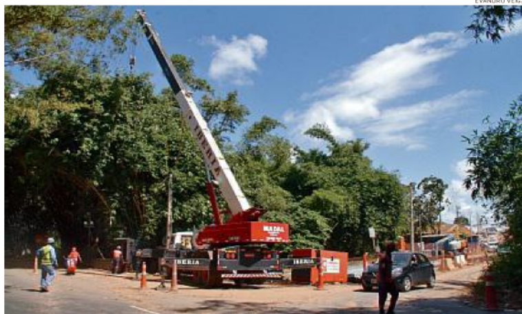
Máquinas já trabalhavam no local ontem; via será alargada para a integração dos ônibus com a estação do metrô
