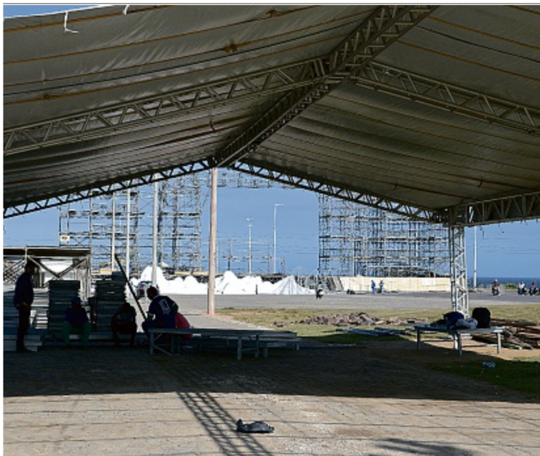
Palco do Festival está em montagem na Boca do Rio
