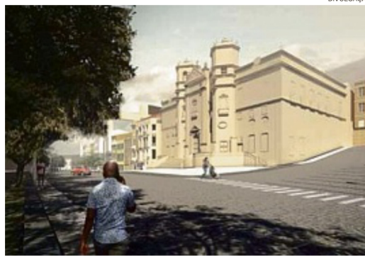
A pavimentação será recuperada, e as calçadas, alargadas
