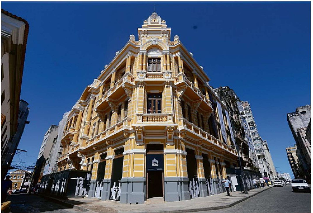
Localizado na Rua Chile, Palacete do Tira-chapéu passa por reforma e vai abrigar restaurantes a partir do próximo ano
