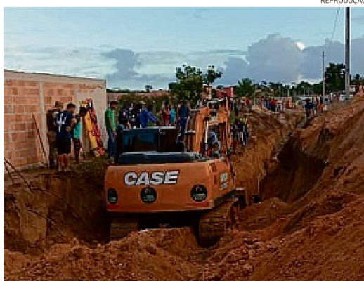
Vítimas escavavam uma vala de 7 metros para instalação de manilhas
