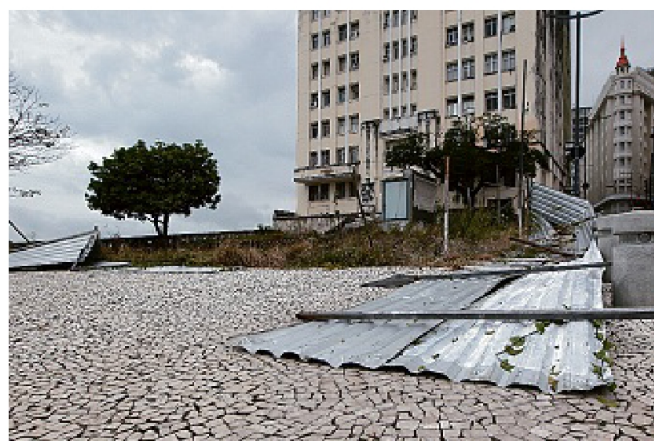
Na Praça Castro Alves, tapumes que isolavam as escavações no local foram derrubados
