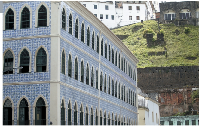
Casarão dos Azulejos Azuis, no Comércio, foi completamente recuperado
