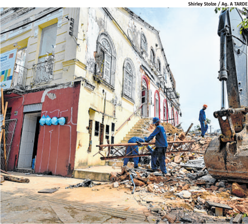
Demolição do prédio ao lado da antiga Sorveteria Campo Grande
