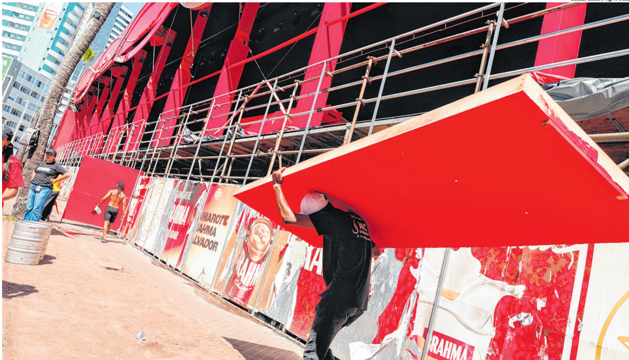
Camarotes são retirados do Circuito Barra Ondina; fiscais da Sedur seguem nas ruas para garantir segurança na desmontagem das estruturas que serviram à folia
