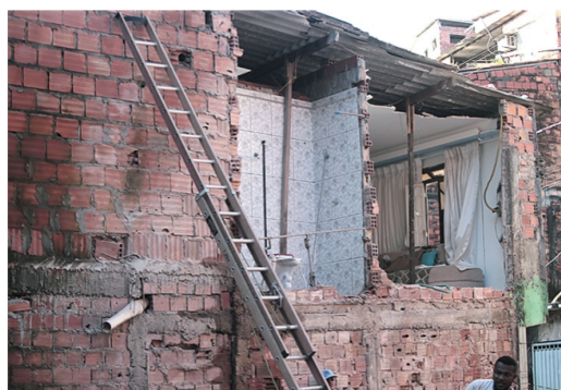
Imóvel vizinho está sendo avaliado e passará por reforma
