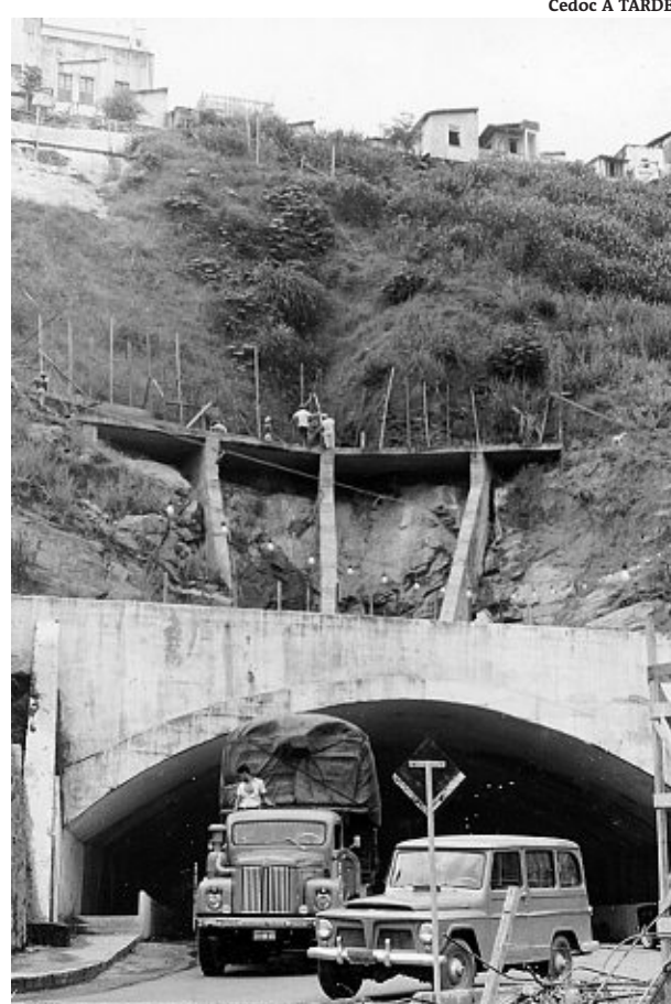
Obras de estabilização da encosta do túnel
