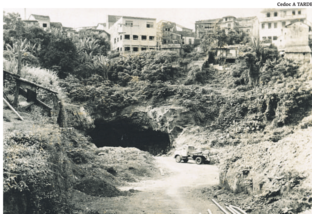
Começo da escavação do túnel; em 1960, as equipes se revezavam 24 horas
