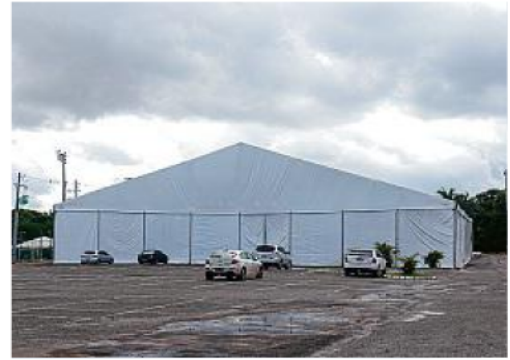
Estrutura não será desmontada e pode voltar a operar caso haja demanda
