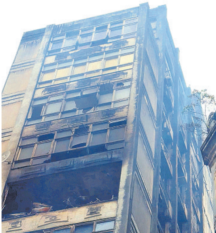
Edifício ficou em ruínas após incêndio sem vítimas
