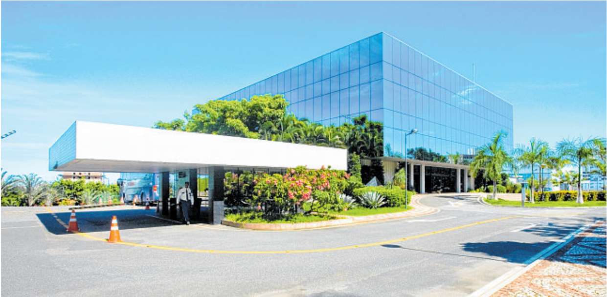
Entre vários projetos emblemáticos, destaque para a Sede da Odebrecht, na Avenida Paralela, em Salvador
