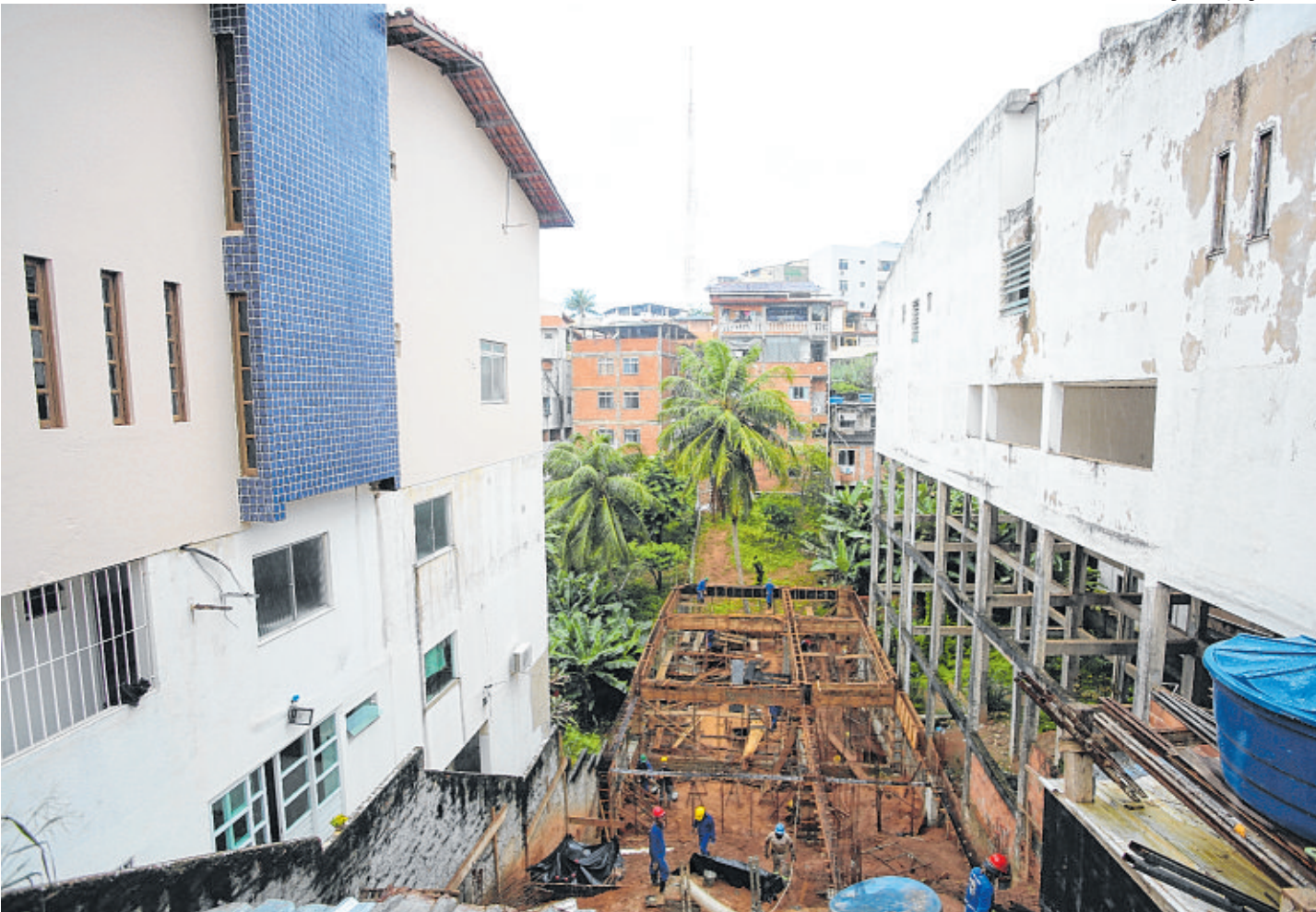
Em construção, o Jardim das Tulipas é um novo empreendimento no Jardim Brasília, uma das áreas mais valorizadas do bairro
