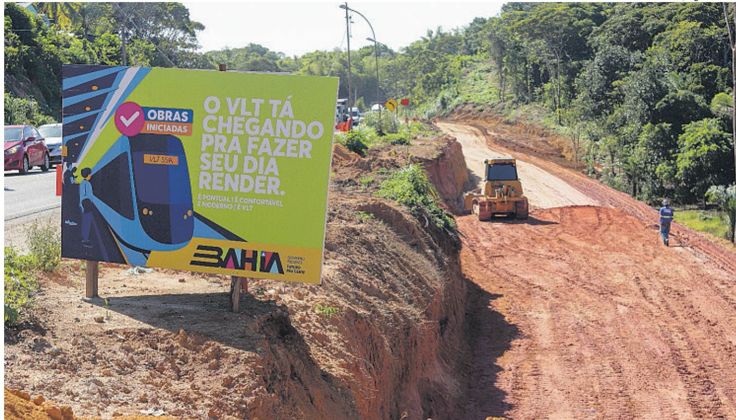
As obras de dois dos três trechos do Veículo Leve Sobre Trilhos já foram iniciadas na Cidade Baixa
