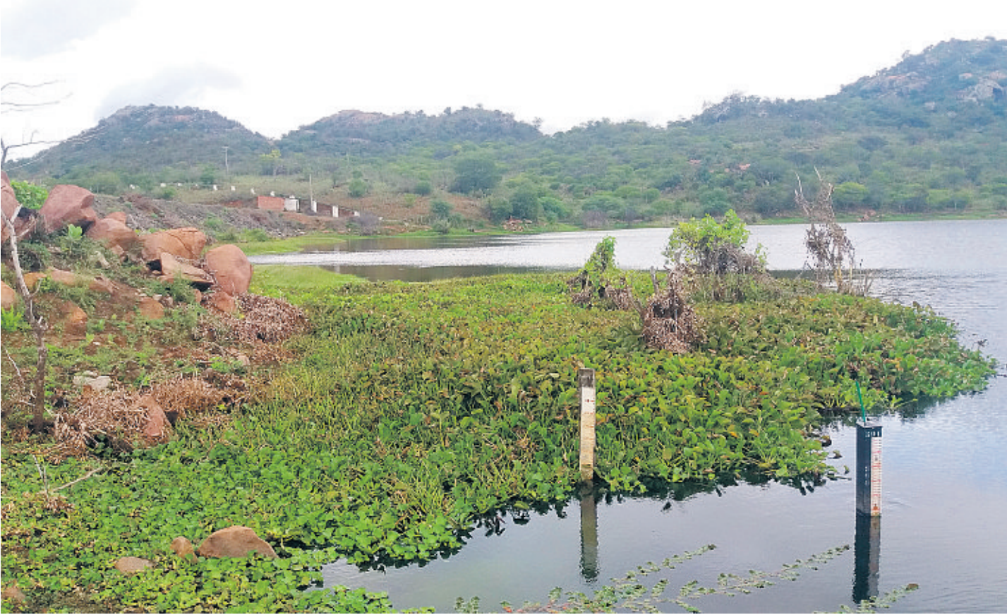
Açudes, adutoras, poços, estações de tratamento e elevatórias são usados na captação de água visando promover segurança hídrica
