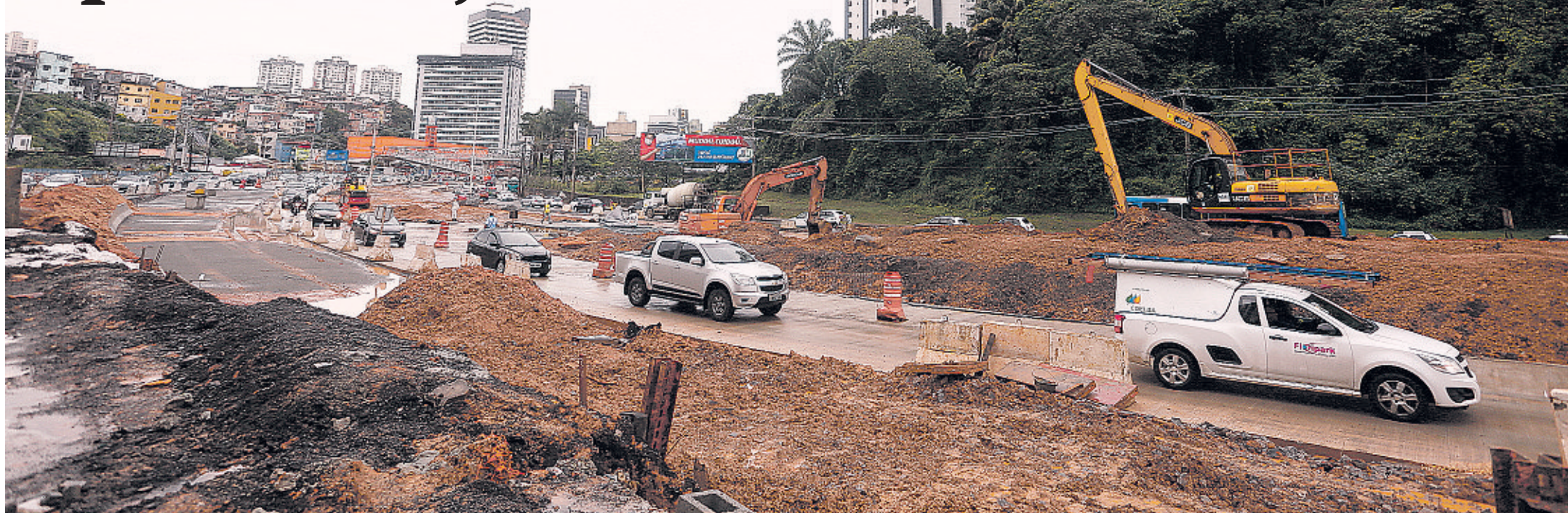
O trânsito na região é controlado em tempo real pela Transalvador mas é visível o impacto das obras na circulação de veículos na AV. ACM, primeiro trecho do projeto
