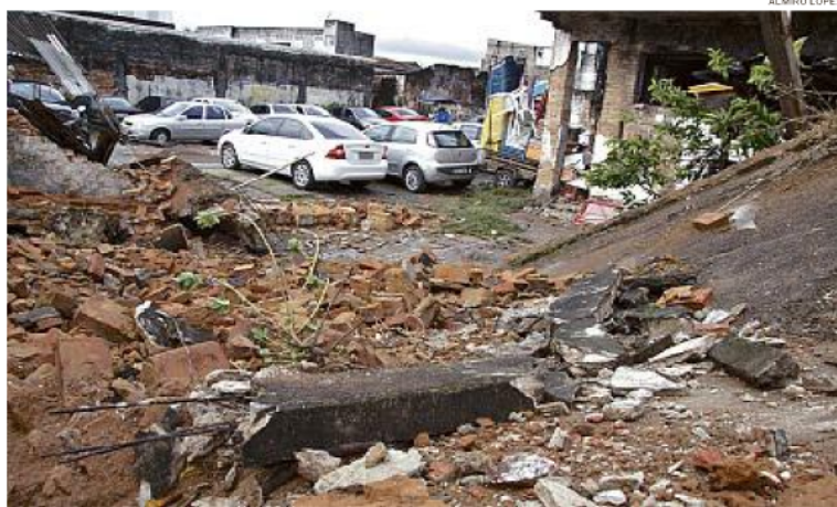
Muro de uma casa na Rua Barão de Cotegepe, na Calçada, desaba e atinge dois carros em um estacionamento
