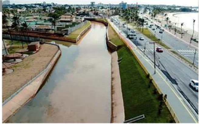
O canal que corta Jaguaribe será desobstruído e terá macrodrenagem
