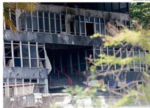
Falta de manutenção e oxidação da estrutura metálica foi a causa do desabamento, segundo laudo do DPT
